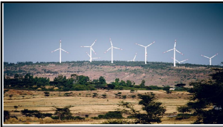
ሥዕል 2.12 የአሸነዳ ንፋስ ሀይል ማመንጫ
